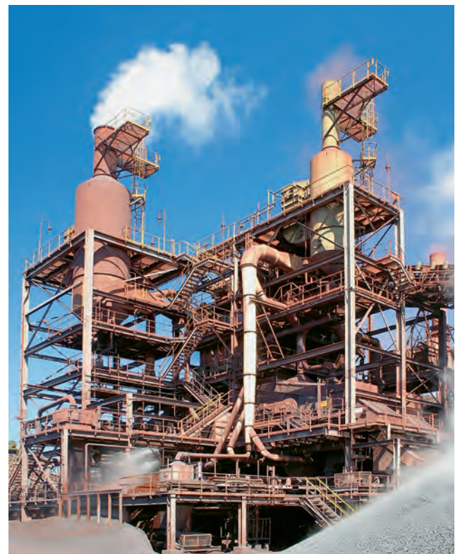
Bild 10: Endklassierung der gehärteten Pellets Fig. 10: Final classification of hardened pellets
