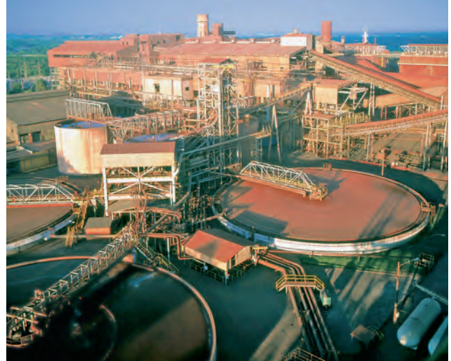
Bild 7: Gesamtansicht der Pelletieranlage
