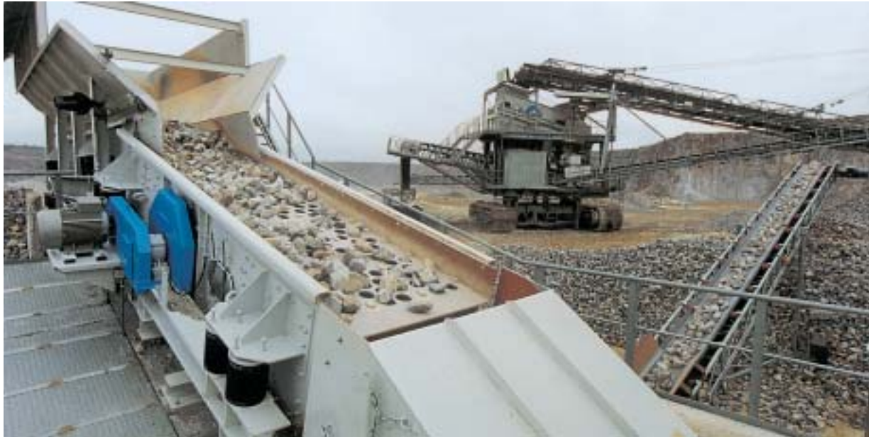
Raupenmobile Siebanlage und Abriebabsiebung von Kalkstein
