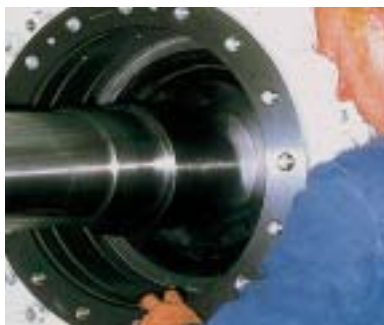
Einbau des Wälzlagers
